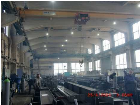
Jedná se o jednopodlažní halu s jeřábovou dráhou (mostový jeřáb o nosnosti 5t - nefunkční, mostový jeřáb o nosnosti 10t - ve vlastnictví nájemce) ze železobetonového skeletového systému s
